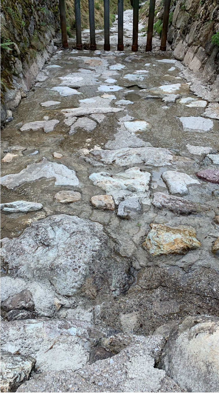
Ripristino seciato alveo
