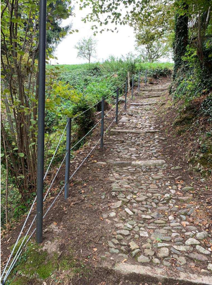
Realizzazione barriera e ripristino sentiero
