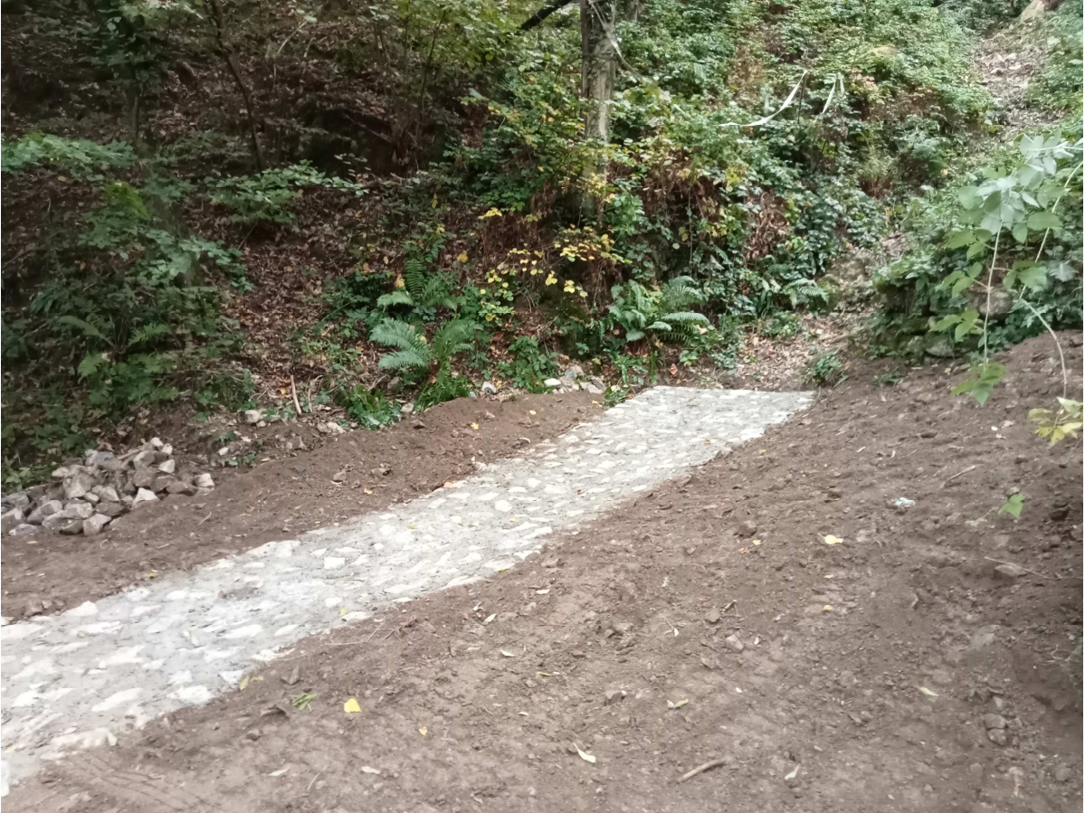
Attraversamento valletta su strada vasp
